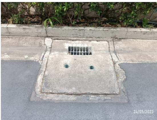
รูปที่ 2-24 บ่อรับน้ำฝน
